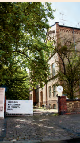
Die Pestalozzischule in Dessau wurde nach langem Leerstand zu einem Treffpunkt für Studierende und Anwohner umgebaut
