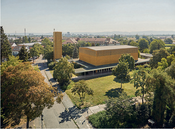
Die katholische Kirche St. Hildegard, gebaut 1961, im Hintergrund die beiden Caritas-Heime und die Bezirkssportanlage (Foto: Daniel Lukac)
